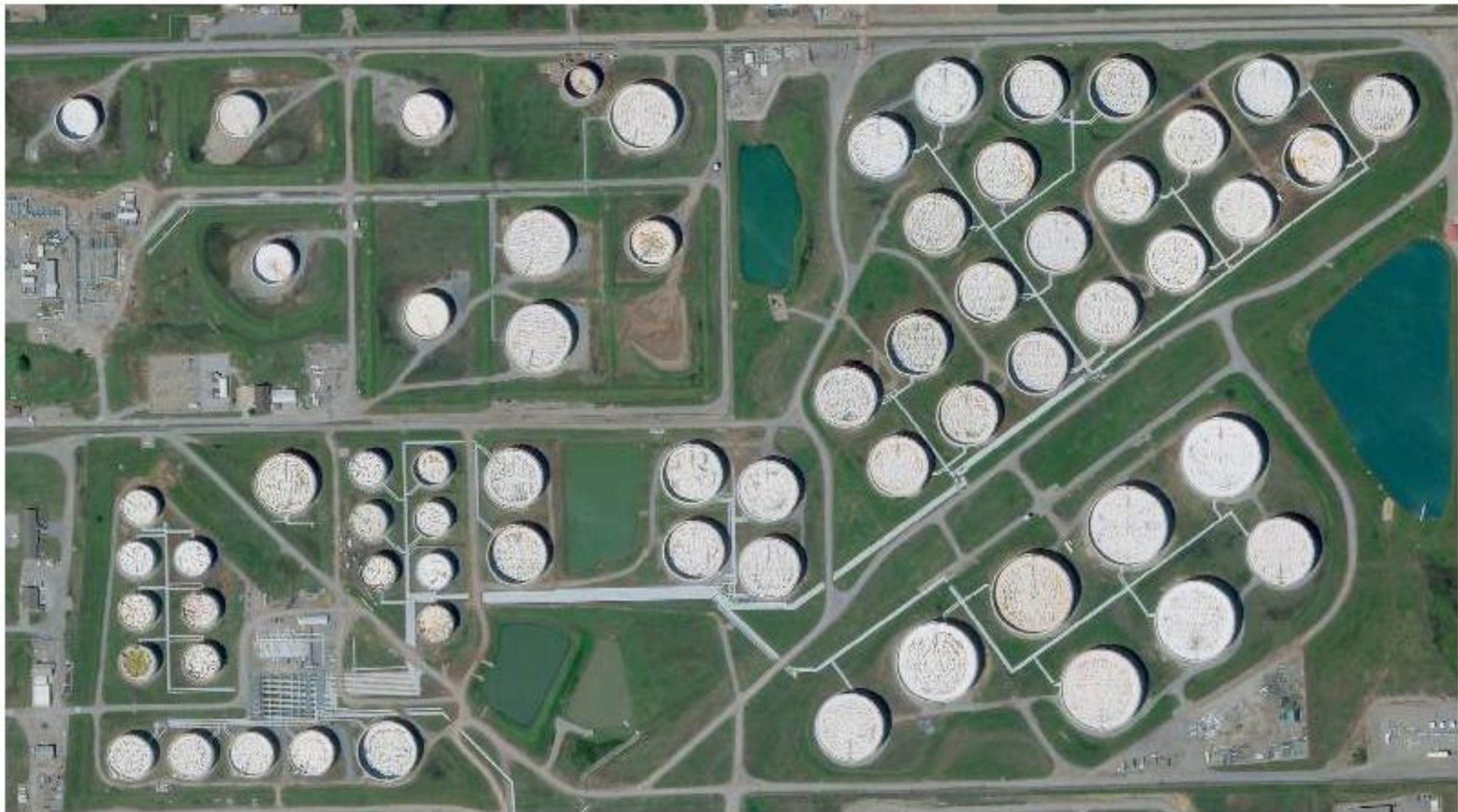
Rohöltanks in Cushing, US-Bundesstaat Oklahoma
